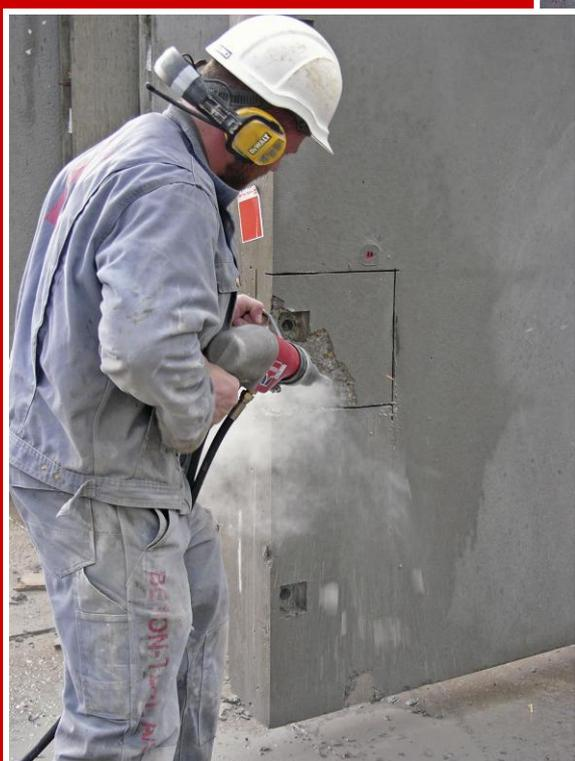
Gracias a su rendimiento tan alto, el HH10RV puede utilizarse para la perforación de cualquier material, también de hormigón duro reforzado.
